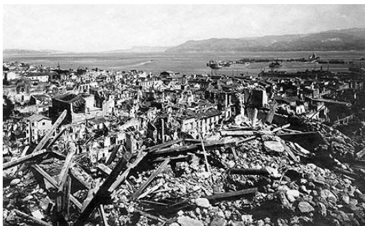
Effetti del maremoto a Messina avvenuto il 28/12/1908. Onde alte fino a mt 12 causarono circa 120.000 vittime
